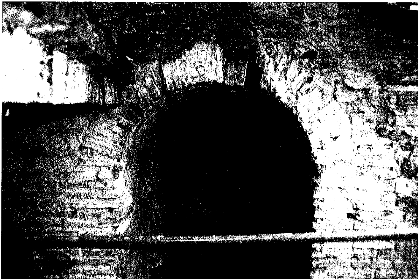
Fig. 20 : Toulouse, 18 rue Sainte-Anne, ouverture dans la construction d'origine de la tour, au-dessus de la courtine sud (cl. O. Gaiffe).
