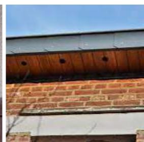
Corniche à martinets © Google
