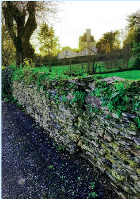
Photographie d'un mur de clôture en schiste dans le département du Maine-et-Loire © UDAP Maine-et-Loire
