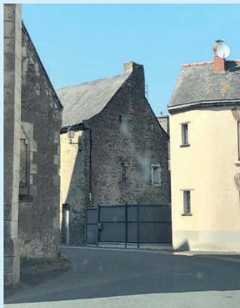
Photographie d'un mauvais exemple d'implantation d'une clôture en secteur protégé © UDAP Maine-et-Loire
