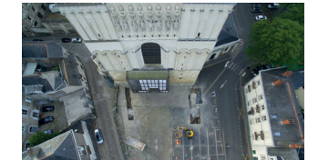
Vue des sondages réalisés sur le parvis de la cathédrale d'Angers © ICOPTAIR 2016
