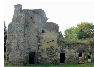
Juillé, le bâtiment antique. À gauche, la tour à sept pans, ses fenêtres à insertion de briques et ses ouvertures médiévales © Inrap
