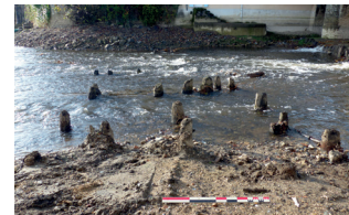
Fondations d'un pont traversant l'Erve à Sablé-sur-Sarthe © M. Lagarde
