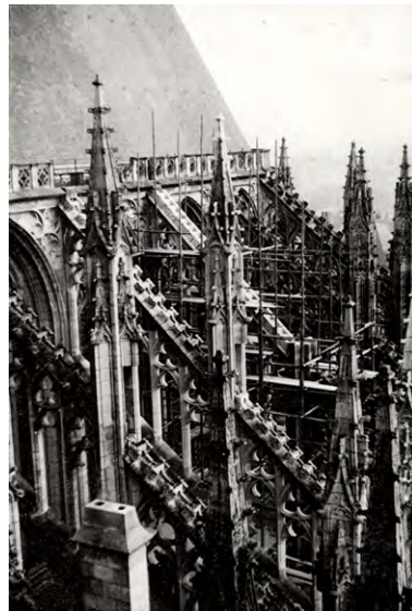
Chœur, façade sud, parties hautes en 1955.
