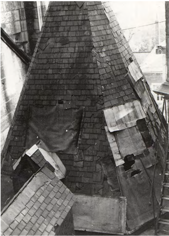
Chœur, toiture de l'une des chapelles en 1960.
