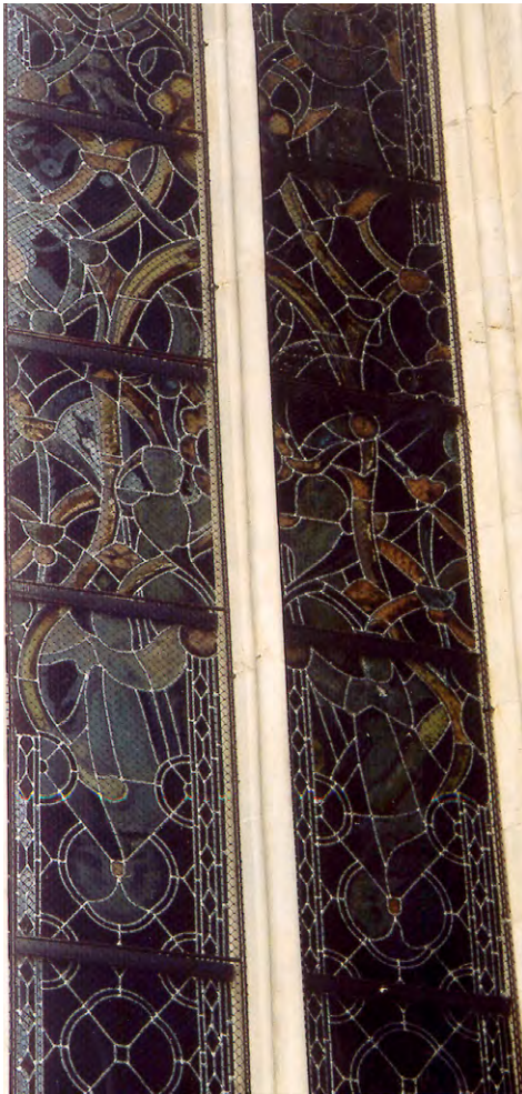
Réseau des plombs de la baie 17 de la chapelle de l' Ecce Homo , vu depuis l'extérieur.
