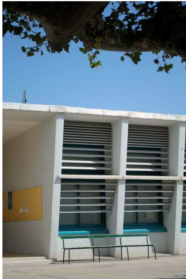
Vue actuelle : détail des fenêtres
