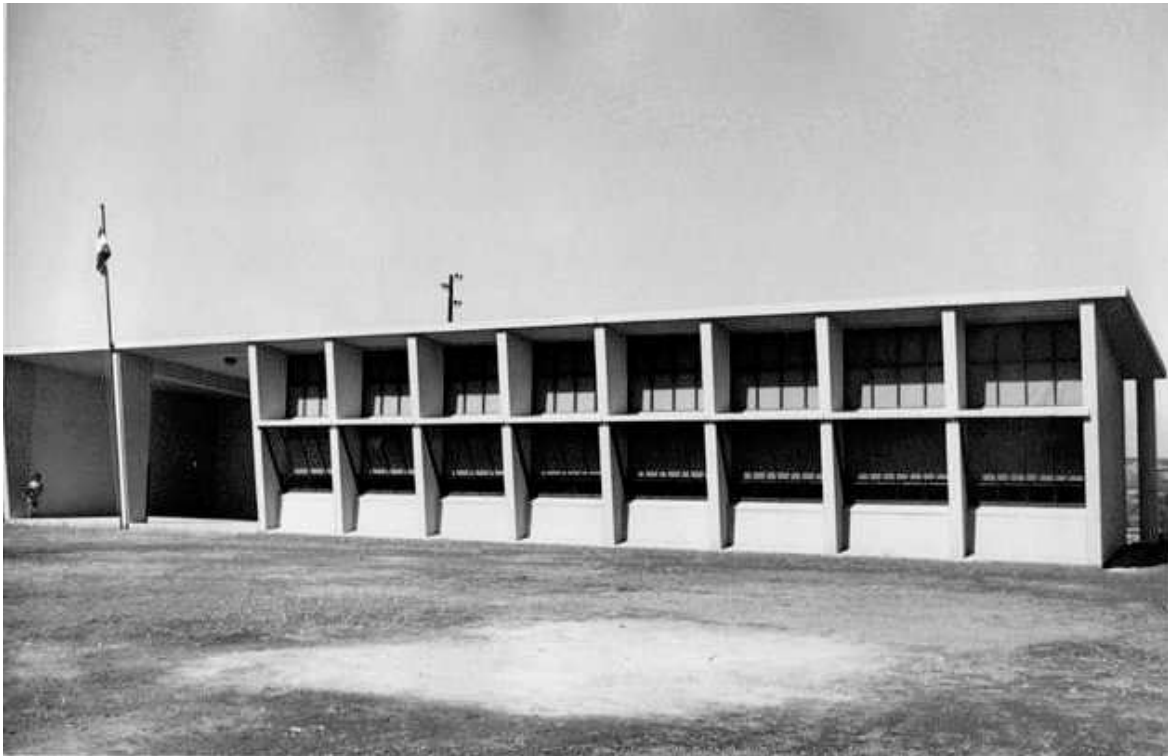
Vue ancienne de l'école : sur la droite le poteau circulaire d'évacuation des eaux
