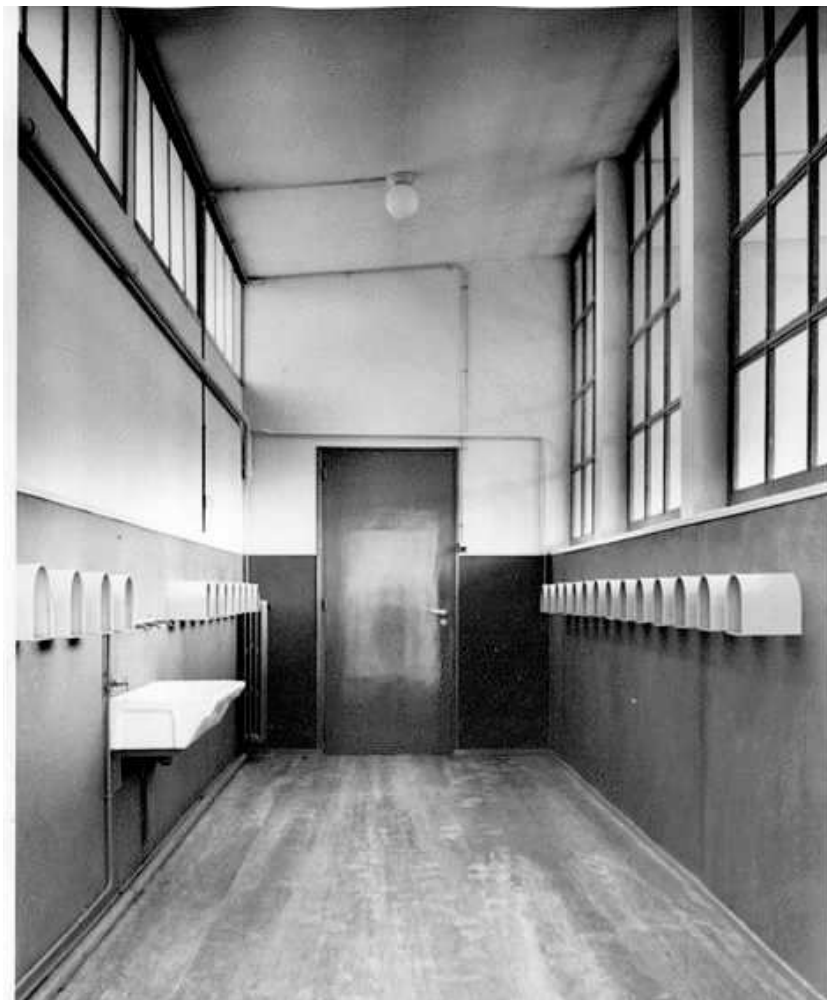
Vue ancienne de l'école : couloir vers la classe avec les boîtes-patères
