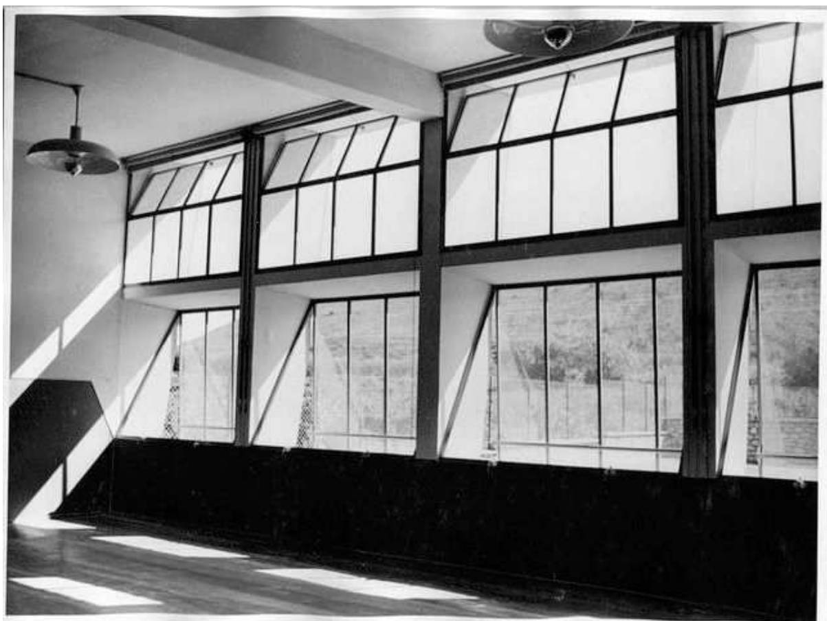
Vue ancienne : détail des fenêtres pendulaires et des brise-soleil
