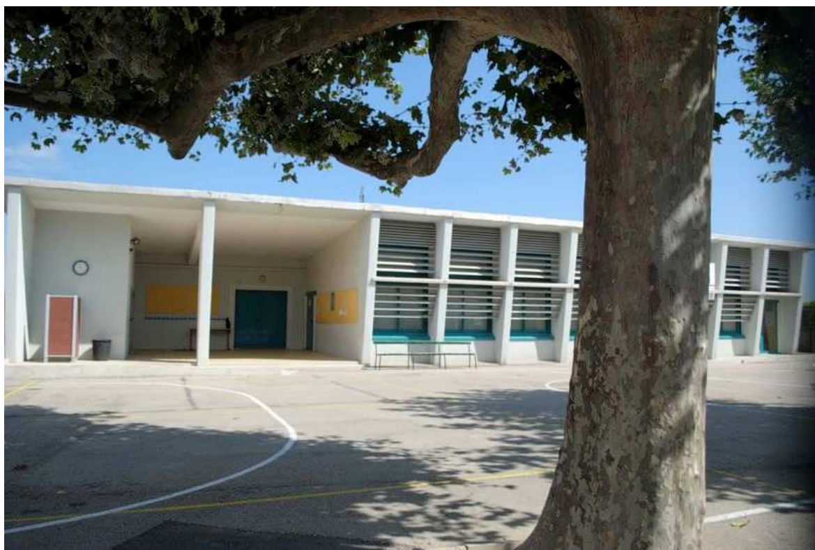
Vue actuelle de la façade sur la cour
