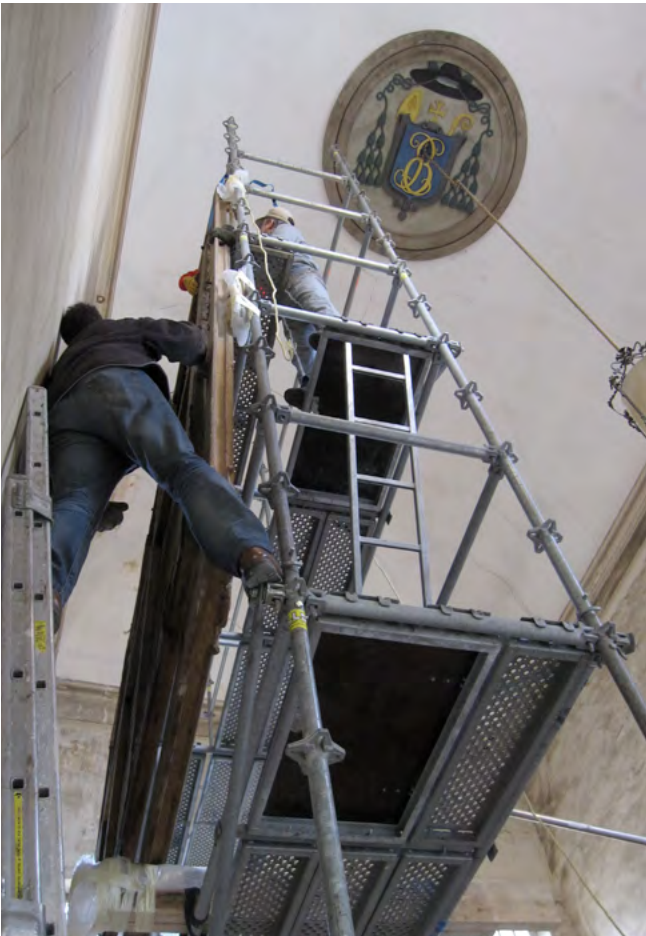
Le tableau est désolidarisé du mur et repose désormais sur l'échafaudage.
