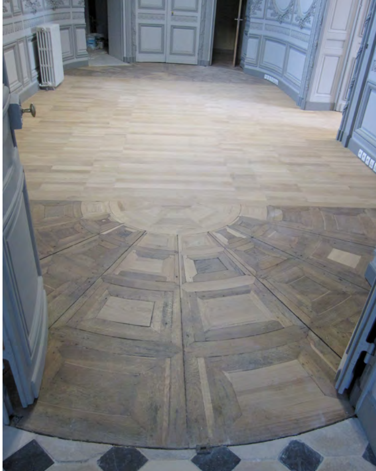
Parquet du vestibule ovale après restauration.
