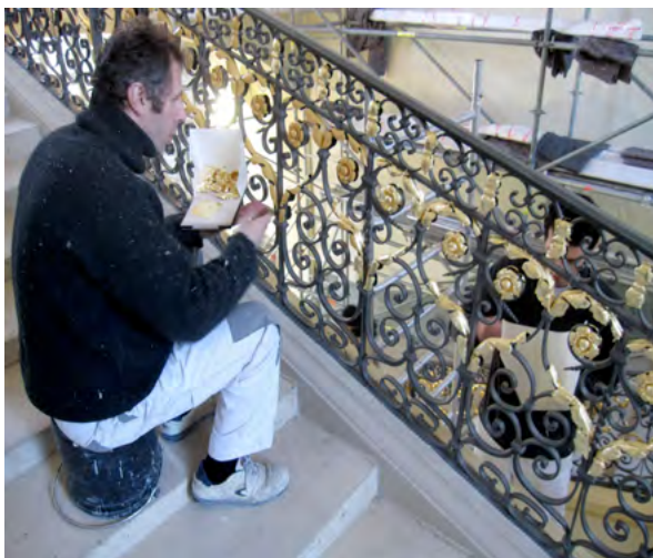
Escalier d'honneur, restauration du garde-corps en ferronnerie.
