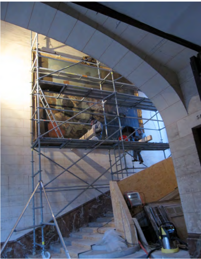
Dépose du tableau : installation d'un échafaudage amovible dans l'escalier d'honneur.
