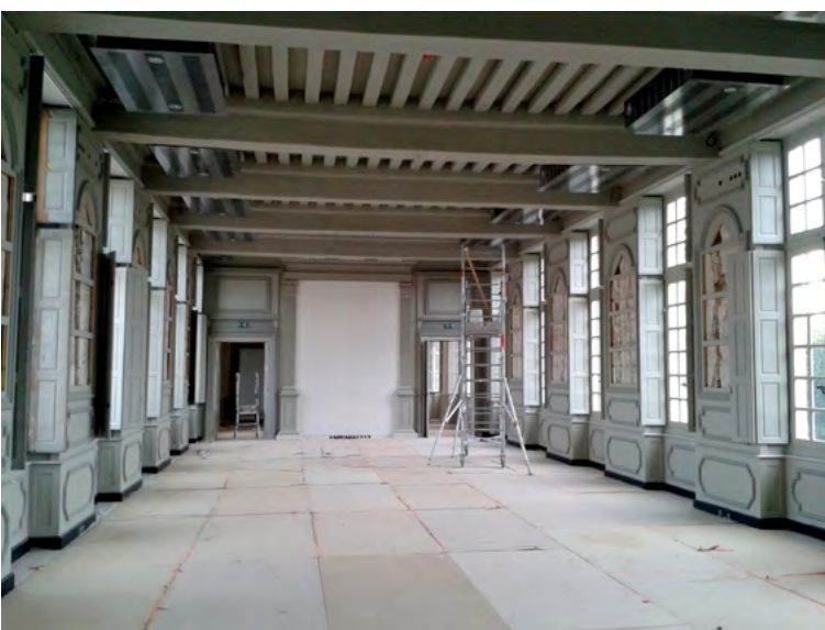
Ancienne salle synodale de l'évêché, en cours de restauration.
