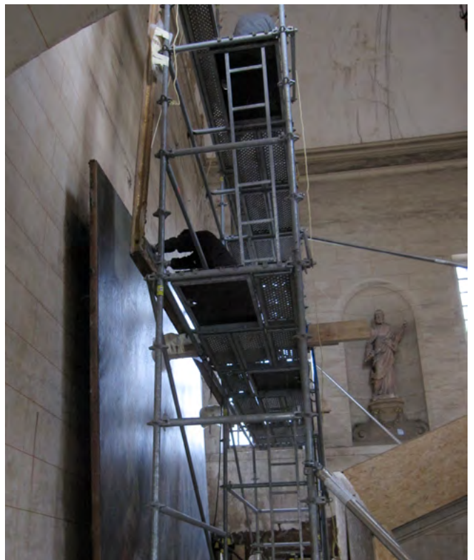
Descente progressive du tableau, séparé de son cadre.
