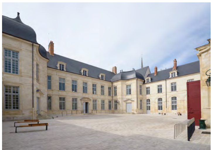
Vue générale de la cour intérieure, après travaux.
