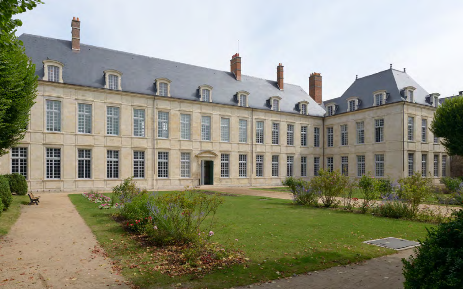
Ci-dessus : corps de logis et pavillon sud vus depuis le jardin, après travaux. Au centre : portail d'entrée sur rue, après travaux. En bas : peintures en faux marbre du vestibule du corps de logis, en cours de restauration.
