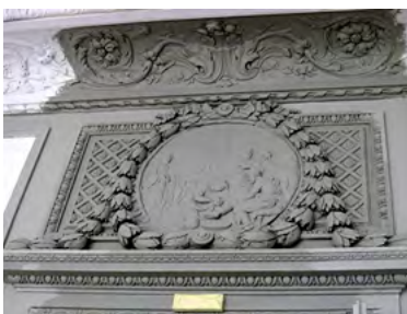
Ancien salon de l'évêque, détail de la corniche du plafond et d'une imposte à relief figurant Le lavement des pieds , en cours de restauration.
