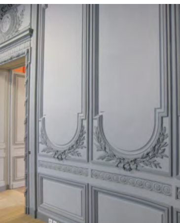
Lambris du vestibule ovale après restauration.
