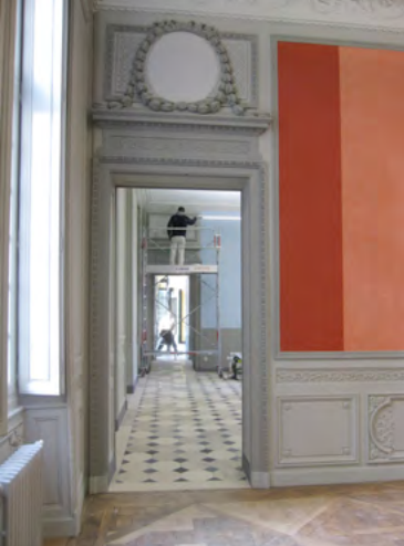
Salons du rez-de-chaussée du corps de logis, à l'ouest du vestibule central : couloir en enfilade, en cours de restauration.
