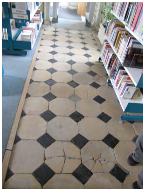
Dallage en pierre du premier salon du rez-de-chaussée, en partie recouvert de moquette à l'époque de la bibliothèque municipale.
