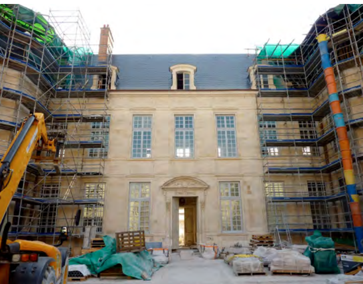
Façades et toitures côté cour, en cours de restauration.
