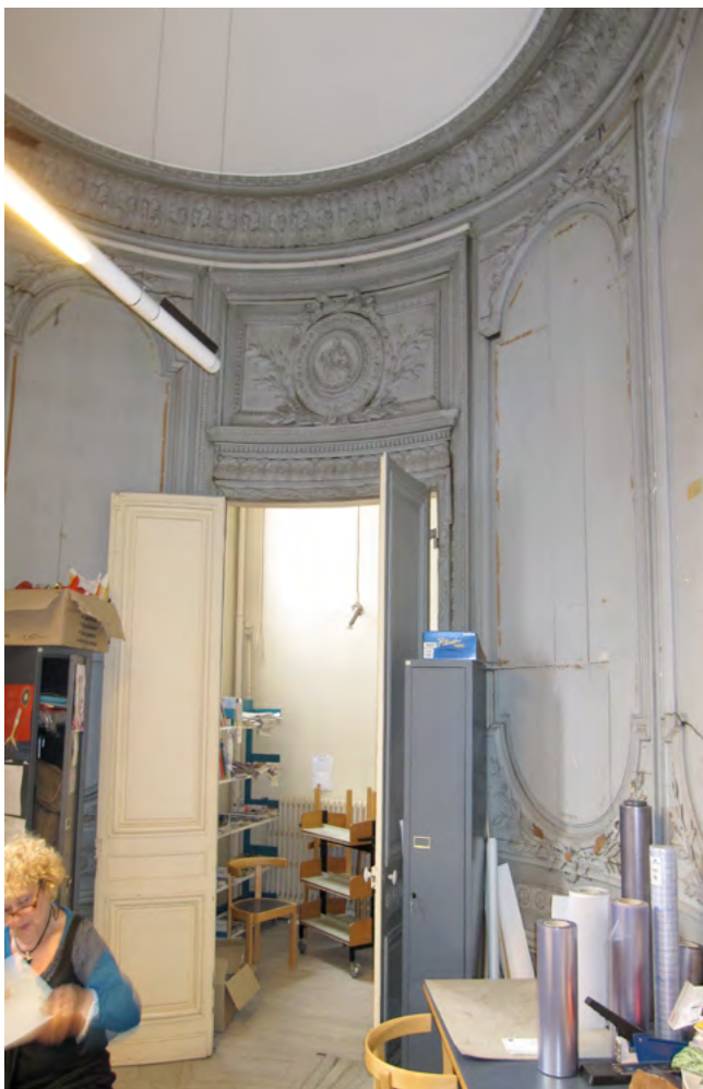
Vestibule ovale aménagé sous l'épiscopat de Mgr Bernier, à l'époque de la bibliothèque municipale.
