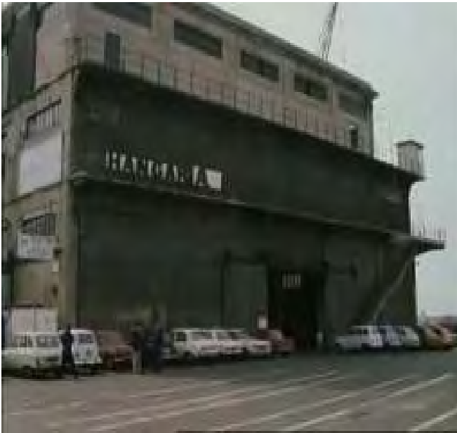
12a) Façade-est du hangar, escaliers externes.
