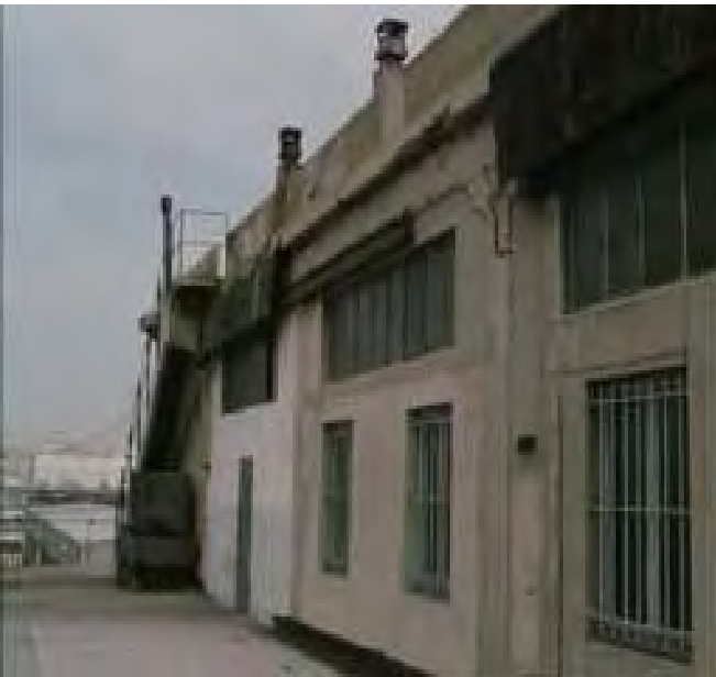
12c) Porte d'entrée au centre.
