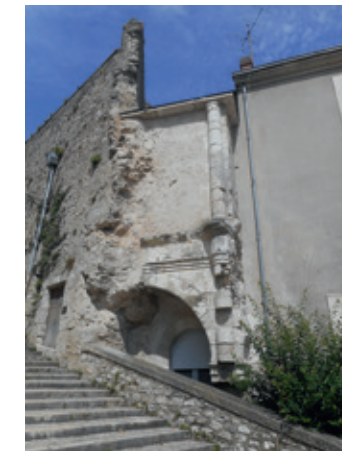
Vestiges de l'église Saint-Martin des Choux situés dans les degrés du Château
