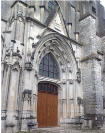
Façade ouest de l'église Saint-Saturnin
