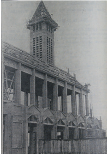
Édification de la Basilique de Blois
