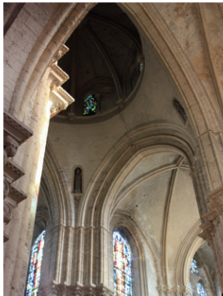
Arcs brisés, voûte d'arêtes et coupole sur pendentifs à la croisée du transept de Saint-Nicolas
