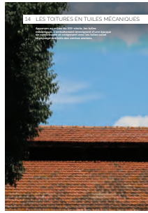
14 les toitures en tuiles mécaniques
