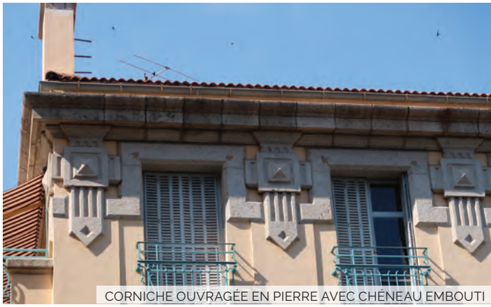
CORNICHE OUVRAGÉE EN PIERRE AVEC CHÉNEAU EMBOUTI
