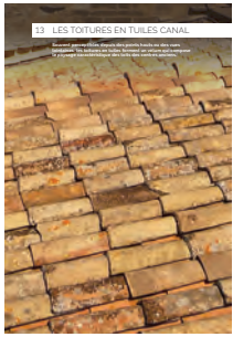
13 les toitures en tuiles canal
