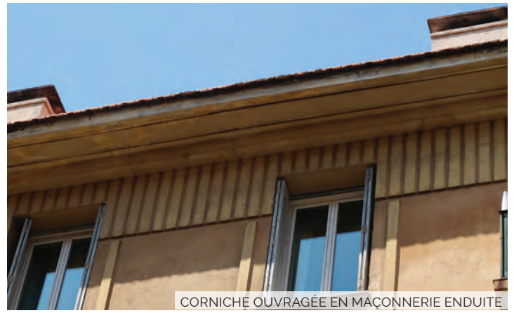
CORNICHE OUVRAGÉE EN MAÇONNERIE ENDUITE
