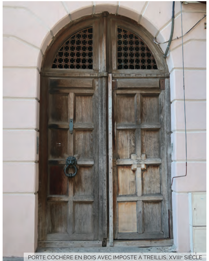
PORTE COCHÈRE EN BOIS AVEC IMPOSTE A TREILLIS, XVIII e SIÈCLE
